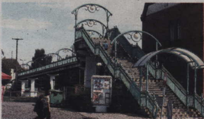
Prace przy modernizacji kwidzyńskiej kładki mają zakończyć się do 10 października.
