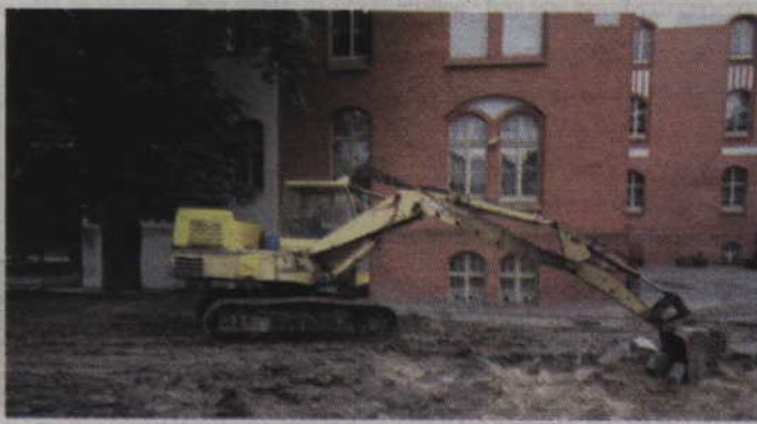
Po zakończeniu prac saperów prace remontowe ponownie zostały wznowione.
