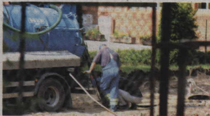
Niewybuchy odkryto podczas prac remontowych przed budynkiem szkoły.
