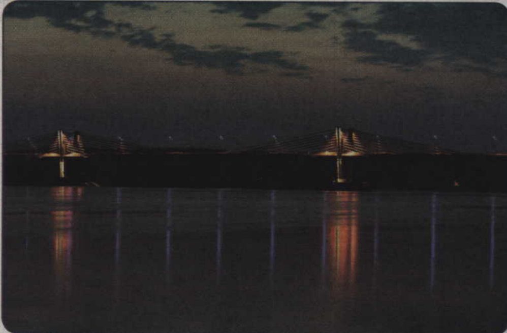
To największa konstrukcja typu extradosed (z ang. Extradosed prestressed bridge ) w Europie oraz jedna z największych na świecie. Most ma ponad 800 m długości. Rozpiętość przęsła wynosi 204 m. Fot. Aleksander Lubiński
