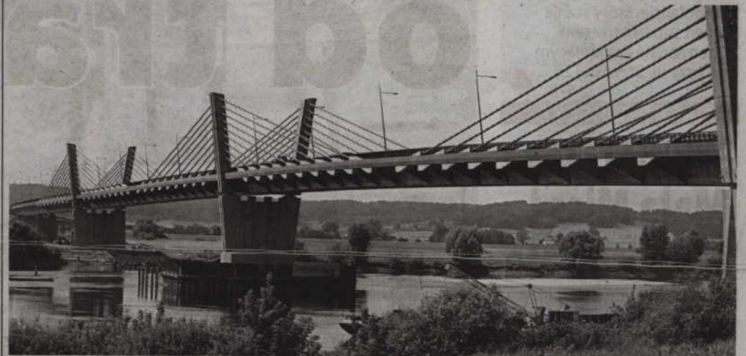
Na ten widok czekaliśmy 20 lat. Most przez Wisłę w okolicach Kwidzyna połączył Powiśle z Kociewiem.
