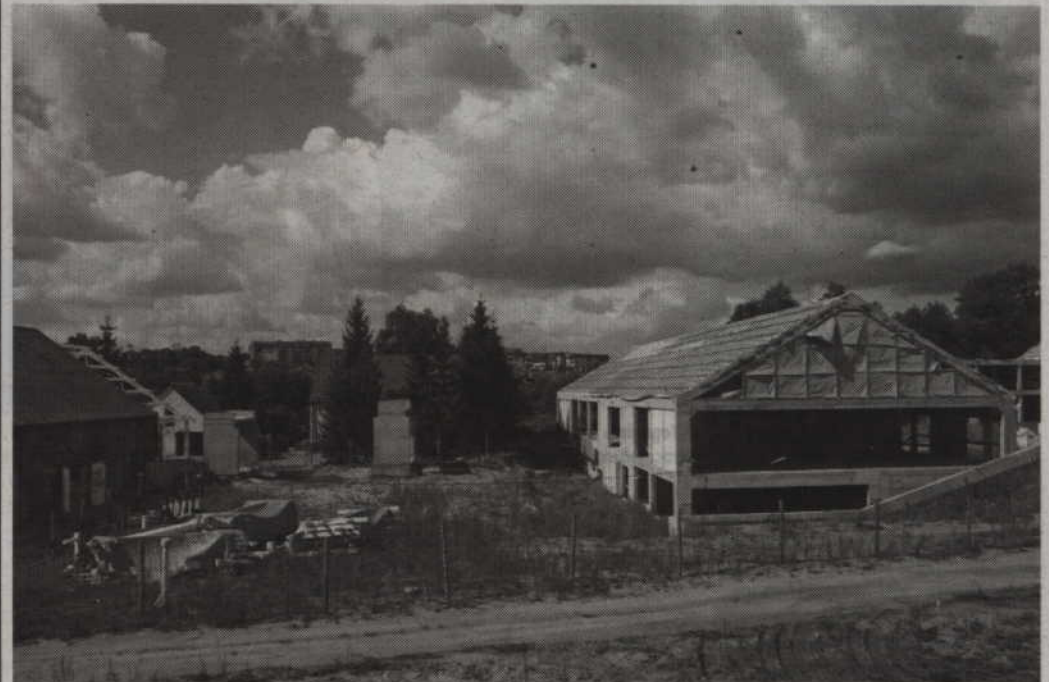
Nowy wykonawca, którego zadaniem będzie dokończenie budowy KPPT w Górkach, ma wejść na teren parku już w listopadzie.
