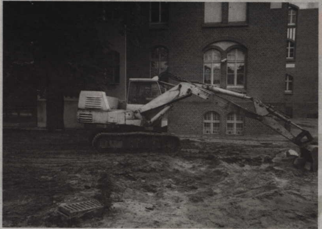
Prace przy powstaniu bezpiecznego wjazdu do SP nr 5 w Kwidzynie powinny zakończyć się do 20 października.
