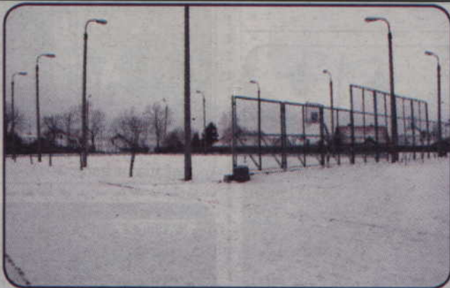
Kompleks boisk zostanie zbudowany przy Szkole Podstawowej nr 4.
