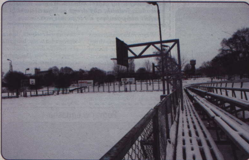
Nowe boisko wielofunkcyjne zostanie wybudowane na terenie stadionu.
