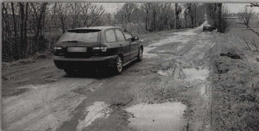
Droga wojewódzka nr 522 w wielu miejscach wymaga gruntownej naprawy.
