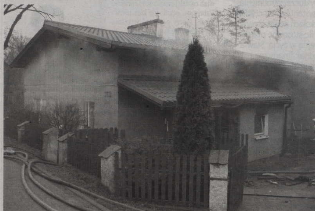
Wybuch gazu uszkodził część dwurodzinnego budynku przy ul. Sportowej.
