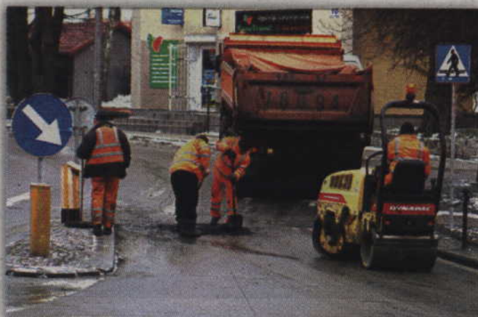
Samorząd powiatu chce, aby remonty wiosenne zostały wykonane w ciągu trzech tygodni. Fot. Mirosław Wiśniewski
