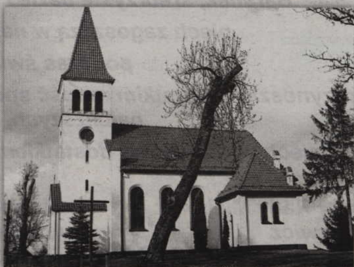
Proboszcz i Rada Parafialna szukają wsparcia koniecznego remontu dachu na kościele w Nowej Wiosce.
