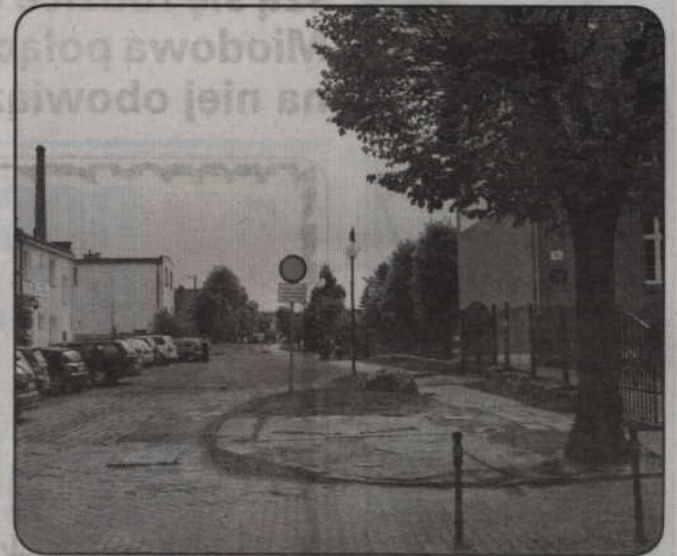
Ulica Miodowa przy Szkole Podstawowej nr 2 zostanie wyremontowana. Powstaną przy niej parkingi. Fot. archiwum
