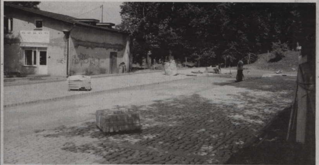
(jk) Prace przy nowym parkingu przebiegają bez przeszkód.
