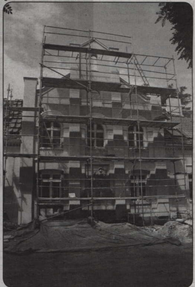
Trwają remonty elewacji kamienic, zarówno należących do miasta, jak i wspólnot mieszkaniowych. Na zdjęciu: remont kamienicy przy placu Plebiscytowym.
