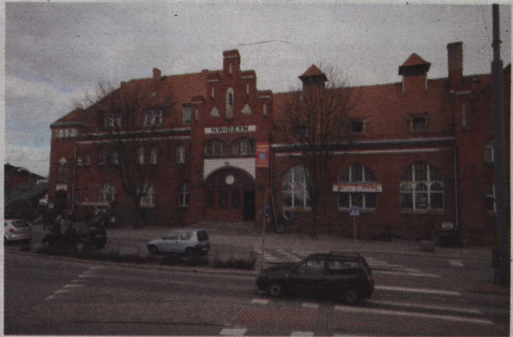
Miasto chce całkowicie zmodernizować nie tylko budynek dworca, ale także jego otoczenie.
