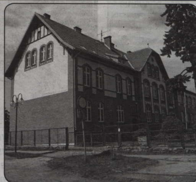
Naprawa dachu i remont poddasza to prace zaplanowane w budynku Szkoły Podstawowej nr 2.
