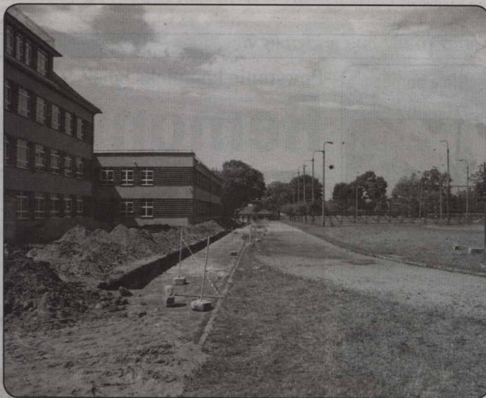
Podczas wakacji we wszystkich szkołach prowadzone będą różne prace remontowe.
