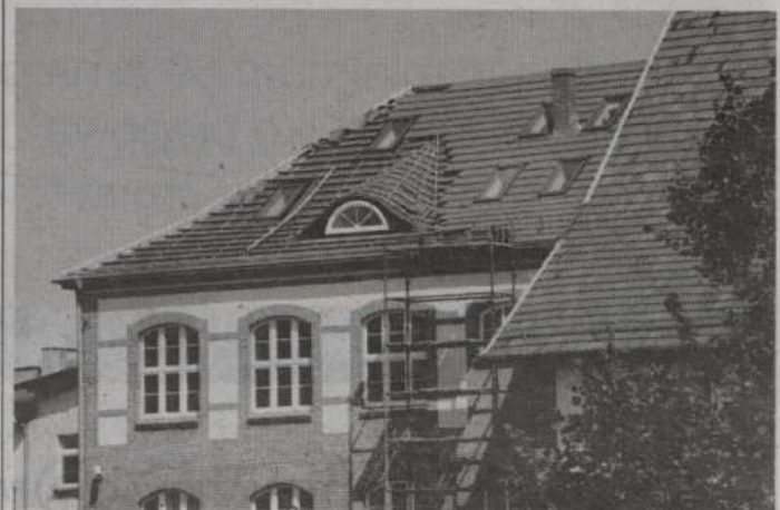
(jk) Nowa sala powstanie na poddaszu budynku głównego szkoły.
