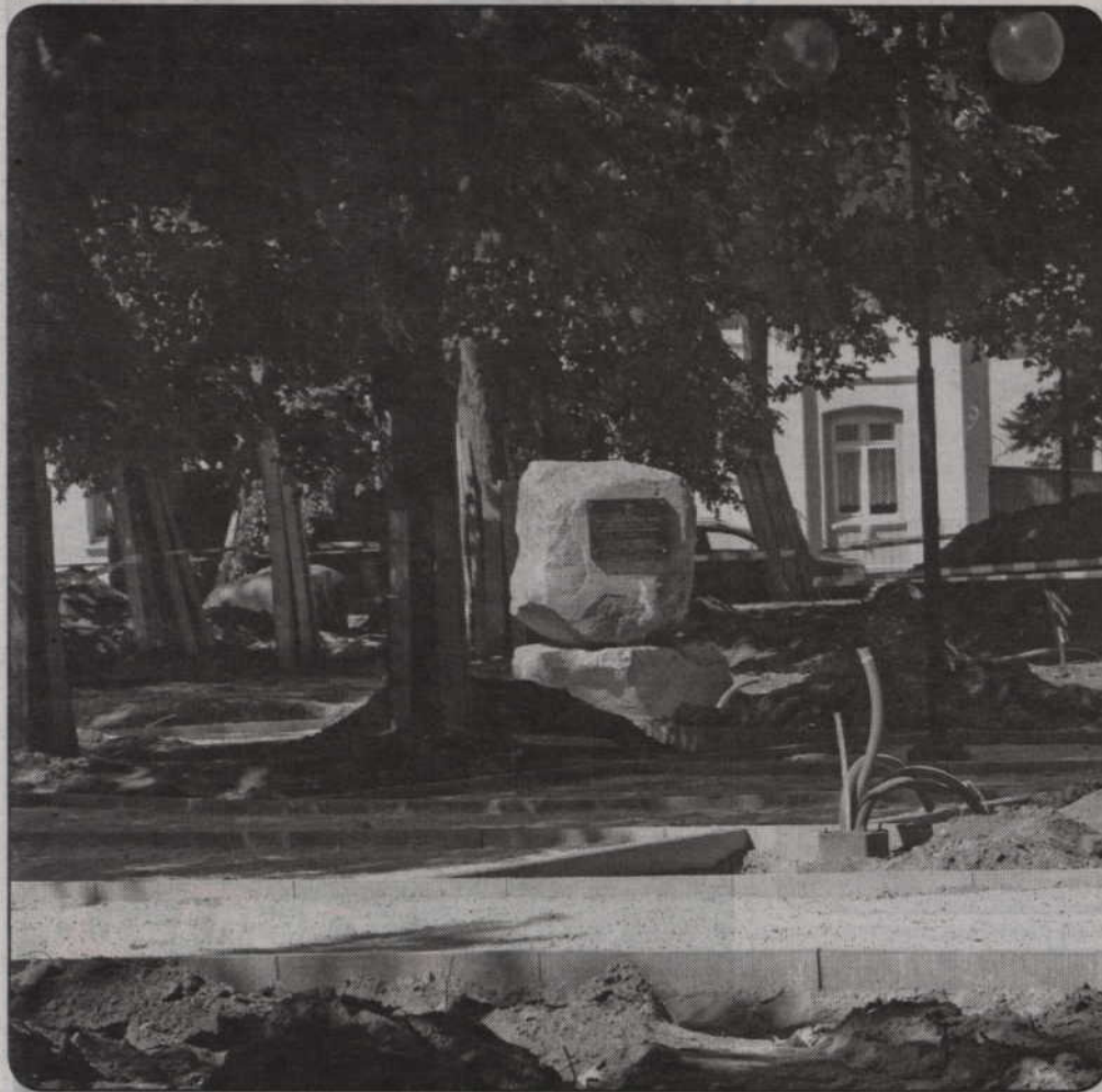
Koszt inwestycji, razem z całą infrastrukturą podziemną i zagospodarowaniem terenu wokół placu, to ok. 1,7 mln zł.
