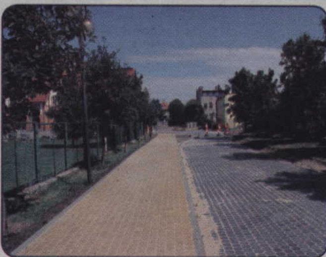
Dobiega końca modernizacja ulicy Miodowej. Powstaje nowa nawierzchnia ulicy. Budowane są także parkingi.
