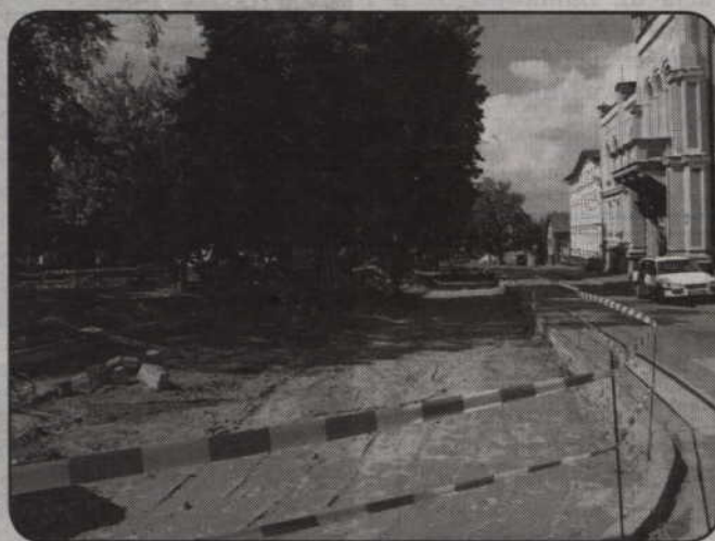
Trwa modernizacja Placu Plebiscytowego.
