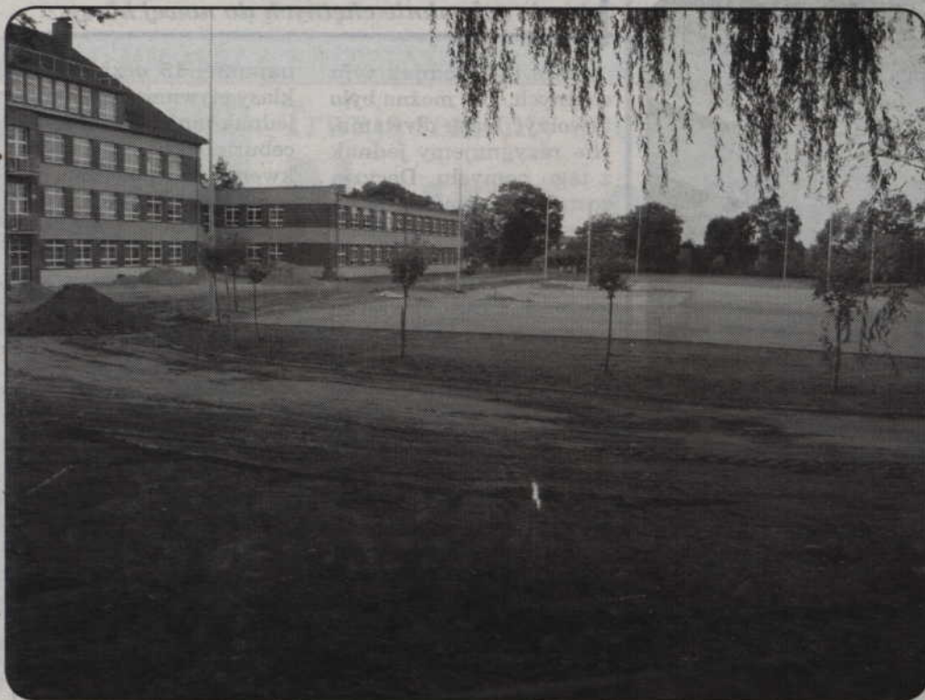
Niektóre prace, zgodnie z wcześniej podpisanymi umowami, będą prowadzone jeszcze we wrześniu. Dotyczy to największych inwestycji oświatowych, jak budowa kompleksu boisk przy Szkole Podstawowej nr 4. Fot. archiwum
