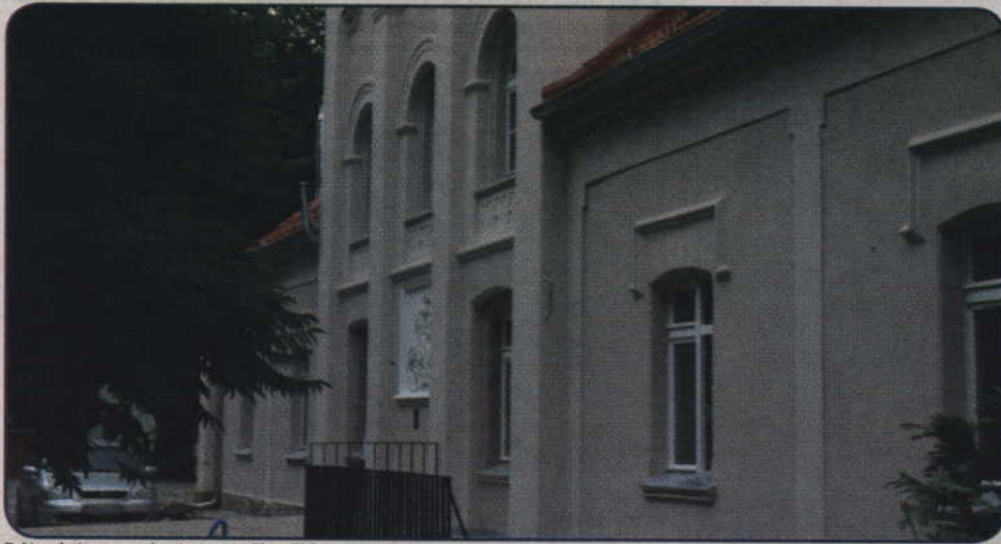
Dobiega końca remont kamienicy przy Placu Plebiscytowym.
