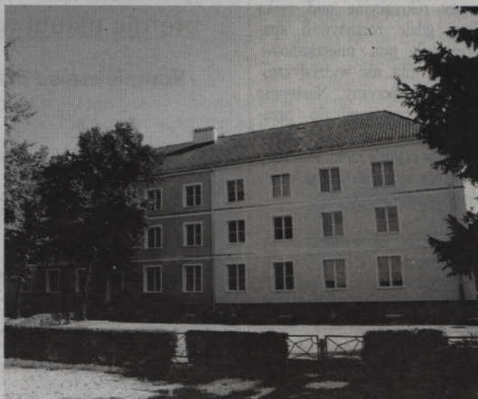
Teren wokół Centrum Kształcenia Zawodowego i Ustawicznego przy ul. Staszica w Kwidzynie zostanie ogrodzony. Powstanie także parking.
