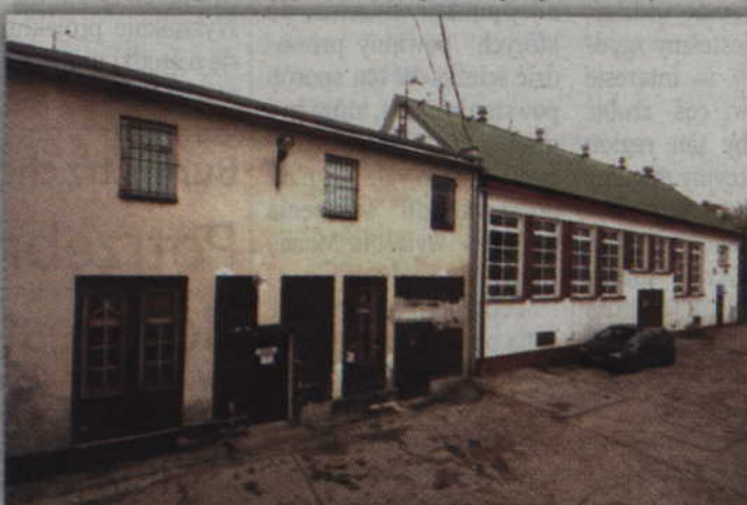
W tym miejscu powstanie przychodnia z kilkunastoma gabinetami. Fot. Mirosław Wiśniewski
