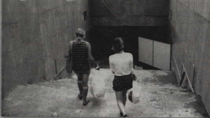
Tunel pod torami i wejście na perony już niebawem będą przyjazne dla osób niepełnosprawnych. Fot. Ryszard Bartosiak/archiwum
