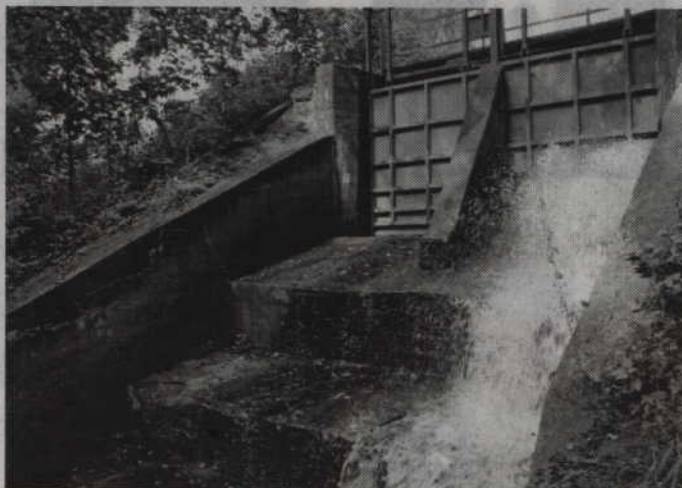
Ponad 142 tys. zł zamierza w przyszłym roku przeznaczyć samorząd powiatu dla miasta Kwidzyna na wykonanie projektu dotyczącego budowy zbiornika retencyjnego na rzece Liwie.
