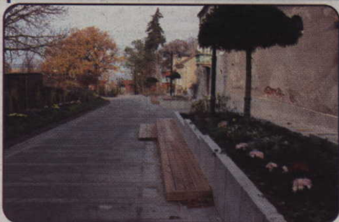
Zakończono większość prac związanych z modernizacją ulicy Zamkowa Góra. Władze miasta chcą jednak wybudować jeszcze najazdy dla wózków. Fot. UMK
