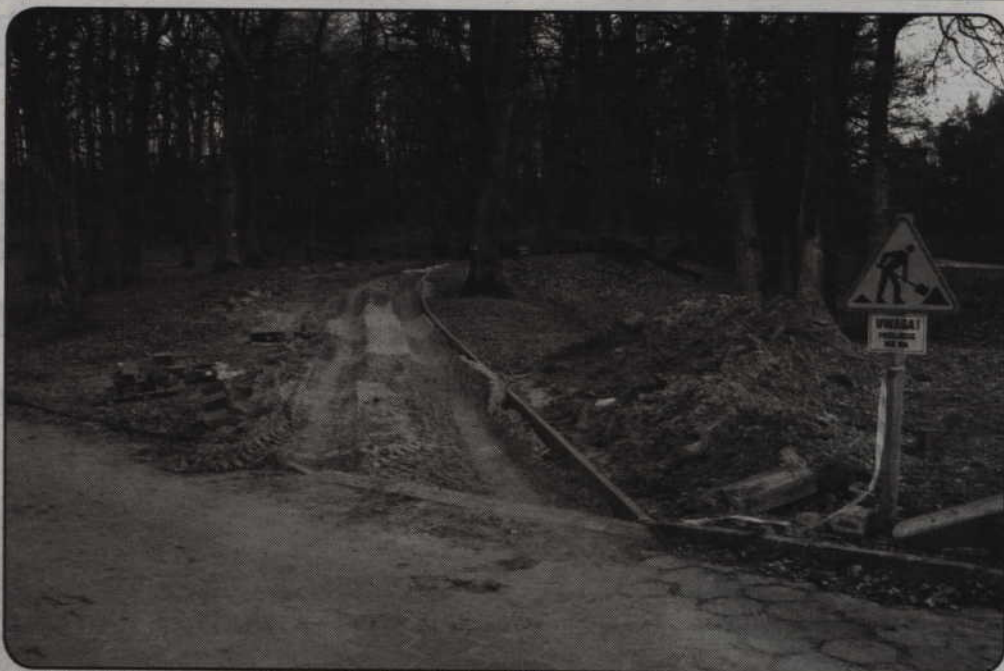
Trwa budowa ścieżki pieszo-rowerowej, która zapewni bezpieczny dojazd do zakładów pracy położonych przy drodze krajowej Kwidzyn-Grudziądz.
