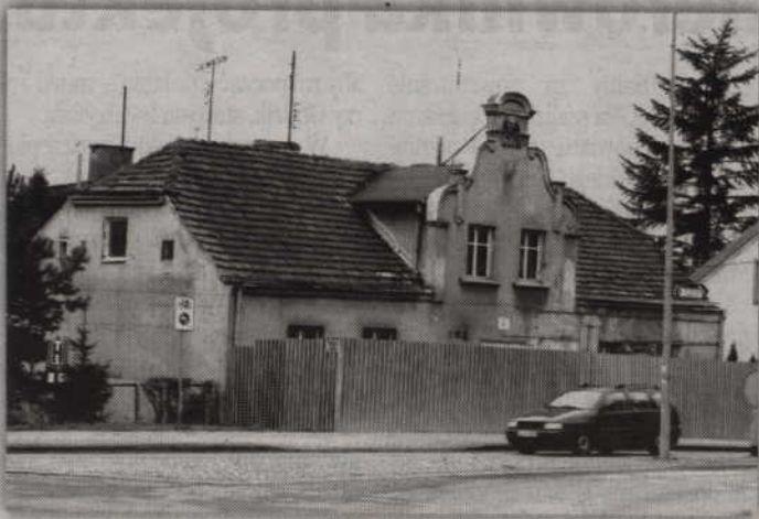
Budynek znajdujący się przy ul. Warszawskiej 42 niebawem przestanie istnieć.
