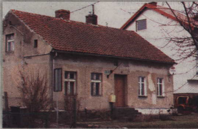
Wyremontowana zostanie zniszczona kamienica przy ul. Piastowskiej 9.
