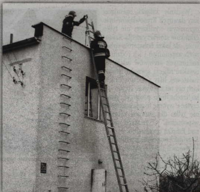
Przypuszczalną przyczyną zdarzenia było zapalenie się sadzy w przewodzie kominowym.
