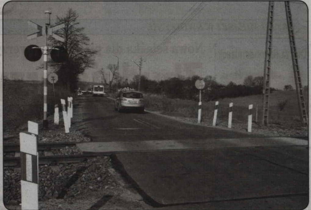
Nowa ścieżka dla pieszych i rowerzystów wybudowana zostanie przy ul. Długiej, na odcinku od torów kolejowych do ul. Malborskiej.
