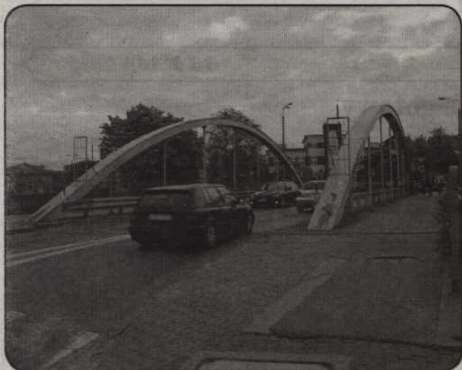
Wiadukt łączący ulice Grunwaldzką i 3 Maja zostanie wyremontowany podczas wakacji.
