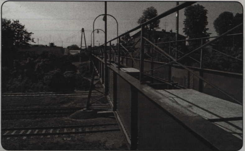
Trwa remont kładki dla pieszych nad torami, w sąsiedztwie Szkoły Podstawowej nr 6.
