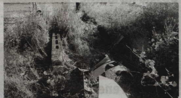
43-latek najpierw uderzył w stojący przy drodze słup energetyczny.
