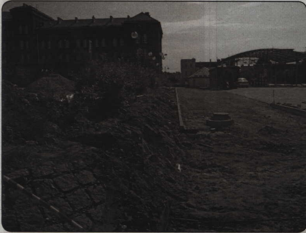
Trwa kolejny etap przebudowy terenu po byłej jednostce wojskowej przy ulicach 11 Listopada i Grudziądzkiej.
