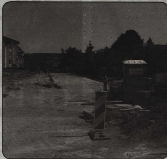
Trwają prace remontowo-budowlane na osiedlu Zatorze II pomiędzy ulicami Broniewskiego, Polną, Reymonta i Słowackiego.
