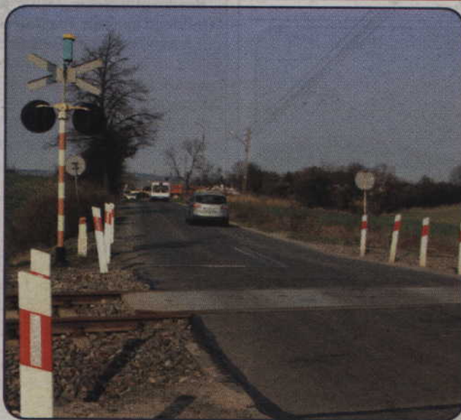
Jest szansa, że budowa nowej ścieżki pieszo-rowerowej przy ul. Długiej rozpocznie się jeszcze w tym roku.
