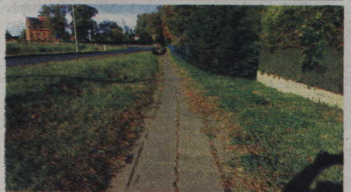
Chodnik na ulicy Rypińskiej jest zapadnięty w kilku miejscach. Powodem jest osuwanie się pobocza drogi.
