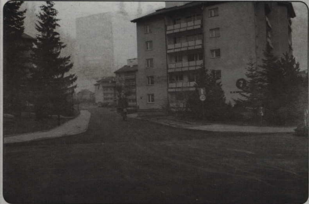
Dobiegają końca prace remontowo-budowlane na osiedlu Zatorze II pomiędzy ulicami Broniewskiego, Polną, Reymonta i Słowackiego.
