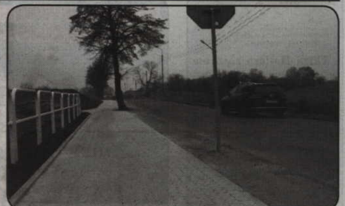
Nowa ścieżka dla pieszych i rowerzystów powstała przy ul. Długiej.
