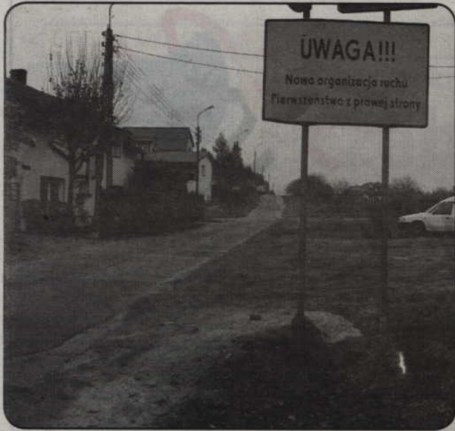
Trwa modernizacja ulicy Owczej. Piotr Halagiera, wiceburmistrz Kwidzyna, informuje, że w chwili obecnej prace obejmują infrastrukturę podziemną. Zakres prac, prowadzonych w trudnych warunkach jesienno-zimowych, będzie zależał od pogody. Fot. archiwum
