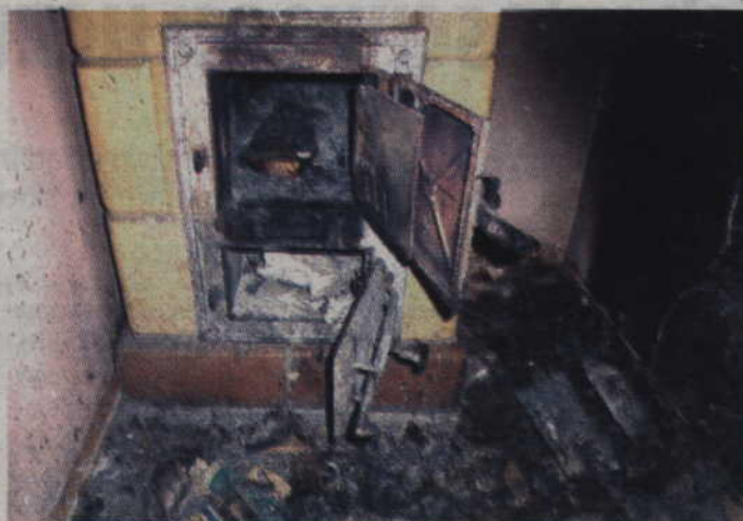
Jedna osoba zmarła w wyniku pożaru jaki wybuchł w mieszkaniu budynku wielorodzinnego przy ul. Braterstwa Narodów. Przypuszczalną przyczyną tragedii było nieprawidłowe składowanie materiałów palnych przy piecu.
