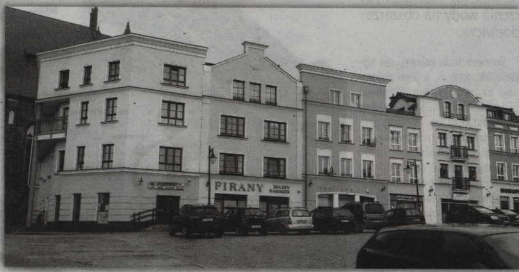
Pierwszy kwartał zabudowy kwidzyńskiej Starówki powstał w 2011 roku. Jesienią przyszłego roku prawdopodobnie oddany do użytku będzie kolejny budynek.
