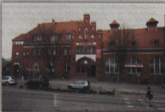
Budynek ma stać się nową siedzibą biblioteki oraz czytelnicy, przy czym zachowana ma zostać funkcja dworcowa budynku.
