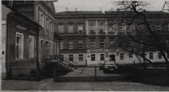
W ramach projektu starostwo zamierza zmodernizować zabytkowy gmach Zespołu Szkół Ponadgimnazjalnych nr 2 w Kwidzynie.
