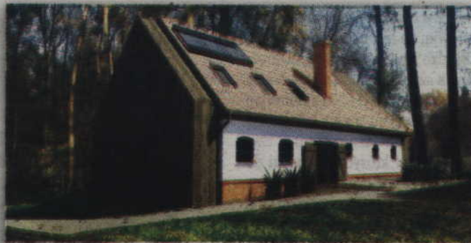
Tak wyglądać będzie wyremontowany budynek gospodarczy znajdujący się przy budynku stowarzyszenia.
