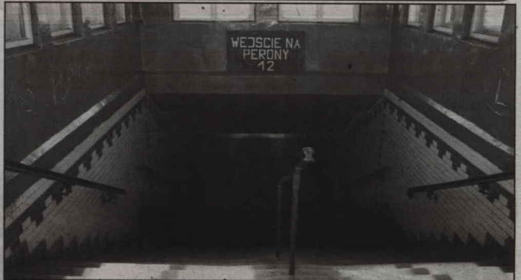
Przy kładce nad torami, w sąsiedztwie budynku dworca PKP powstanie przejście podziemne prowadzące bezpośrednio na perony. To jeden z elementów przygotowywanej modernizacji dworca oraz całego przyległego terenu.
