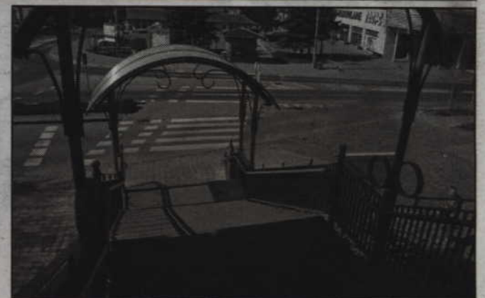
Dodatkowe zejście przy schodach było jednym z uzgodnień miasta z PKP.
