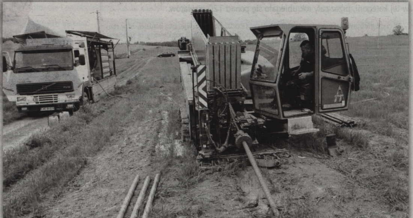
- Wzrost liczby odbiorców wody powoduje spadek ciśnienia wody w kranach dlatego musimy wymienić rury, aby nie dochodziło do takich awarii. Robimy to posilując się firmą, która wykonywała 4-kilometrowy odcinek nowej sieci wodociągowej - wyjaśnia Zbigniew Piotrowski, kierownik ZGK w Gardei.
