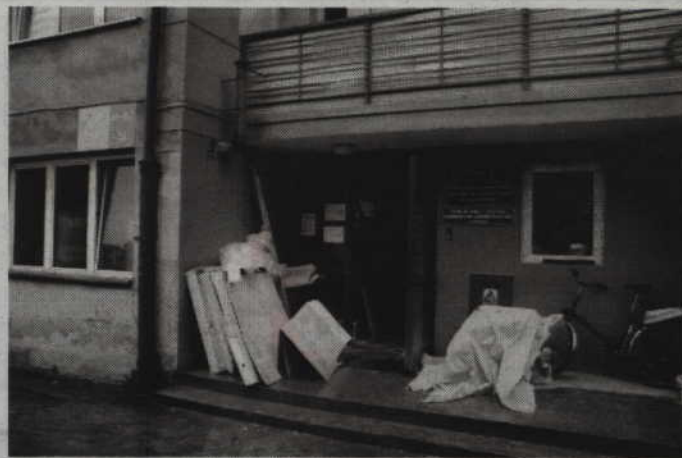
Prace w budynku internatu są już na ukończeniu
