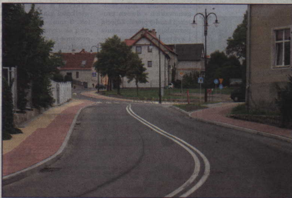
Nowa nawierzchnia została położona na ulicy Żwirki i Wigury, na odcinku od skrzyżowania z ul. Sztumską do ul. Łąkowej.
