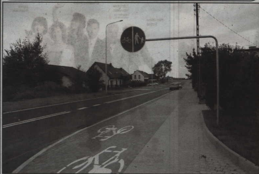
Dobiegła końca przebudowa ulicy Owczej.
