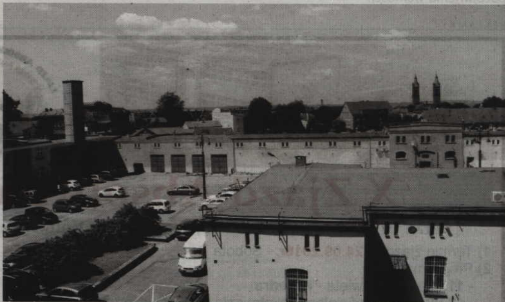
Budowa pasażu, który połączy miejsca do parkowania za gmachem starostwa z terenem targowiska przy ul. Kopernika ma poprawić sytuację związaną z parkowaniem. Fot. Jacek Kluczkowski
