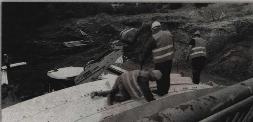
Opieszalego podwykonawcę zastąpiła inna firma i prace na moście nabrały tempa. OGŁOSZENIE
