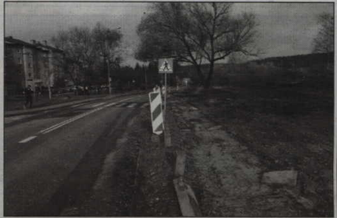
Wybrany został wykonawca, który zbuduje parking i chodnik przy ul. Zielnej.
