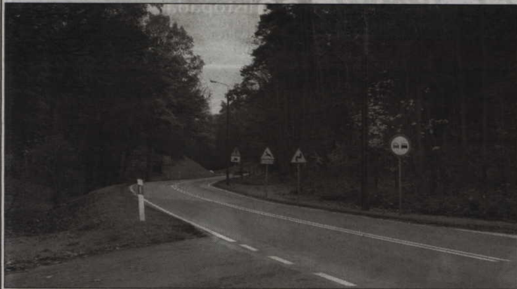
Wykonane zostaną nowa nawierzchnia, pobocza i chodnik przebiegający wzdłuż osiedla Miłosna.
