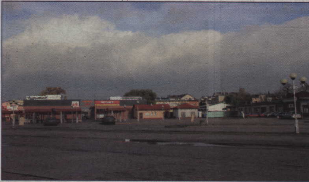
Do końca roku ma zostać wykonane przejście łączące teren targowiska przy ul. Kopernika z parkingiem położonym przy budynku starostwa.
