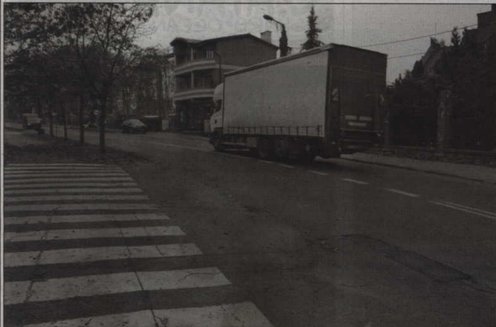
W ramach inwestycji planowana jest przebudowa istniejącej jezdni i jej poszerzenie, budowa ścieżek rowerowych, przebudowa chodników oraz istniejących już zatok parkingowych i autobusowych, a także budowa nowych zatok. Fot. archiwum
