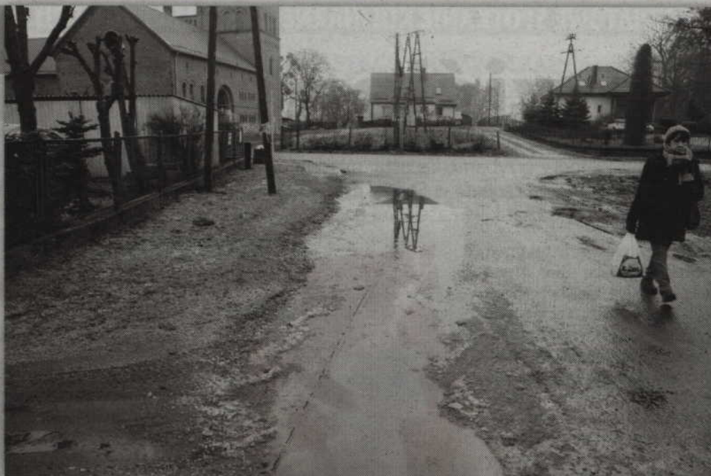
Duża kałuża powstaje nawet po niewielkich opadach deszczu.
