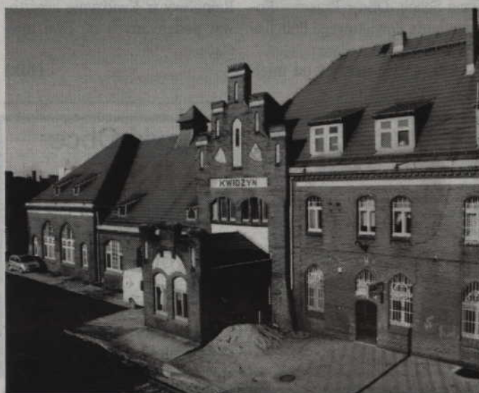
Modernizacja kwidzińskiego dworca, wraz z budową tzw. węzła integracyjnego trwać będzie 2 lata. Fot. archiwum
