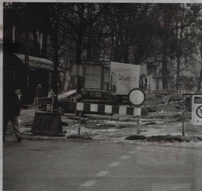
Na modernizowanej ulicy Hallera prowadzone są obecnie prace ziemne.
