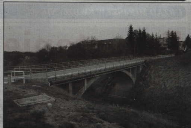
Jeszcze w tym roku samorząd miasta zamierza poszerzyć wiadukt na ul. Owezej.
