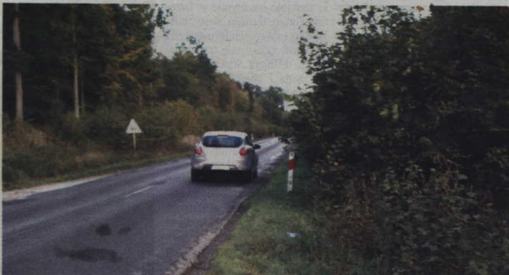
Modernizacja drogi wojewódzkiej nr 521, łączącej Prabuty z Kwidzynom, zakończyć ma się pod koniec przyszłego roku.
