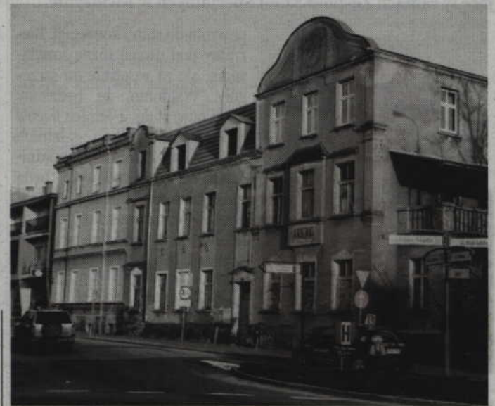
W zmodernizowanej kamienicy u zbiegu ulic Słowiańskiej i Kościelnej powstaną 13 lokali czynszowych.
