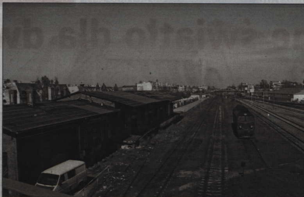
Równoległe z modernizacją budynku dworca ma ruszyć modernizacja linii kolejowej Malbork-Kwidzyn-Grudziądz.
