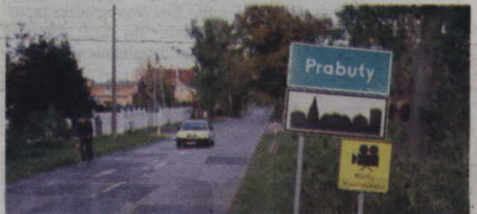
Mieszkańcy proszą o bieżącą naprawę ubytków i dziur pojawiających się na drodze Prabuty - Kwidzyn.
