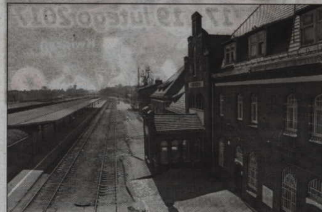
Koszt realizacji całego projektu to ok. 17 mln zł. Inwestycja ma zapewnić bardzo dobre warunki osobom korzystającym z różnych form komunikacji kolejowej i autobusowej.
