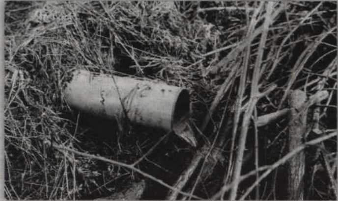
W tamie blokującej odpływ wody położono specjalną rurę, która odprowadza niewielkie ilości wody.
