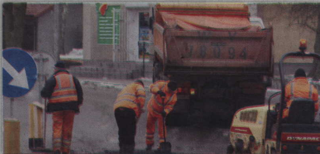
- Tam gdzie ubytki są głębsze, będzie trzeba wycinać masę bitumiczną i nałożyć nową - wyjaśnia włóczęgowie Andrzej Fortuna.
