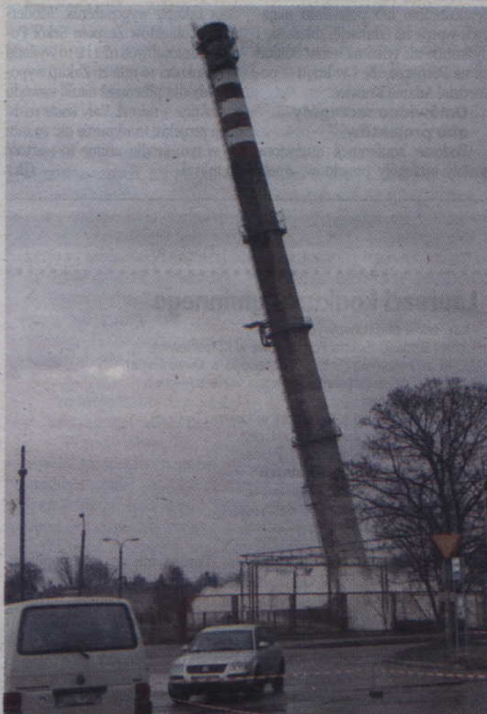
Do wysadzenia kominą użyto 25 kg dynamitu.
