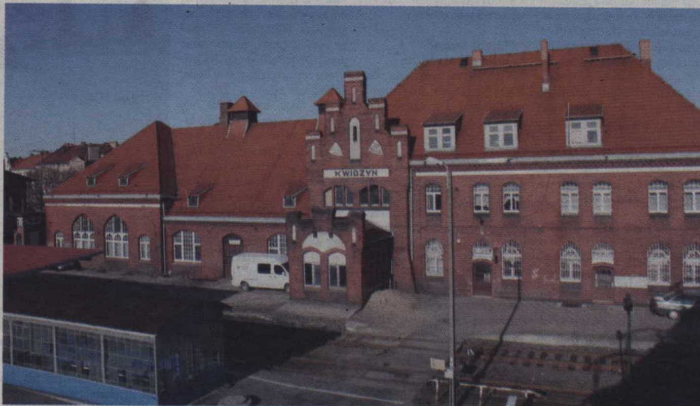
Prawdopodobnie na początku maja wybrani zostaną wykonawcy, którzy zajmą się budową tzw. węzła integracyjnego oraz modernizacją budynku dworca PKP. Fot. archiwum
