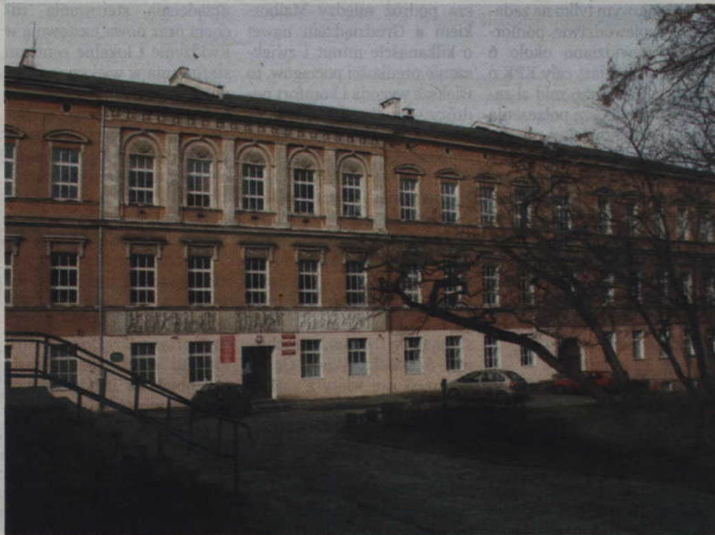
Przetarg na modernizację budynku ZSP nr 2 trzeba było powtórzyć. Zaproponowane ceny przekraczały kwotę zaplanowaną na realizację tej inwestycji.
