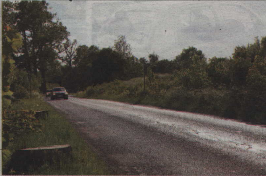
Drogowcy w pobliżu Raniewa wytną całą skarpe, więc niebezpieczny zakręt zniknie na zawsze.
