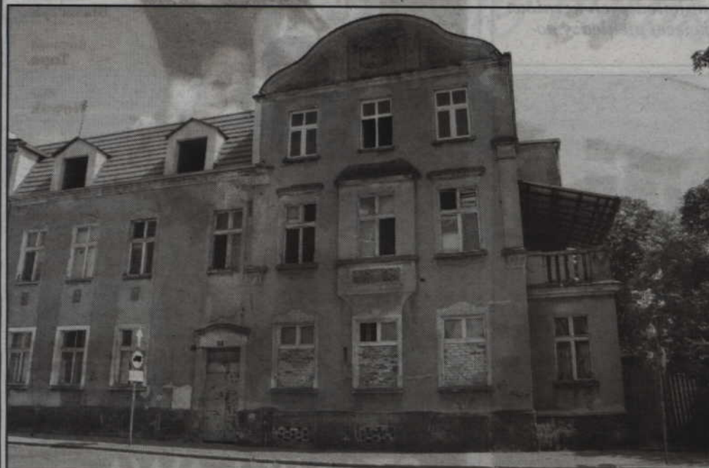
W budynku zakupionym przez miasto powstanie 12 mieszkań, po cztery na każdym piętrze. 10 lokali będzie dwupokojowych. Jedno mieszkanie będzie miało trzy pokoje. Powstanie też tzw. kawalerka. Fot. archiwum
