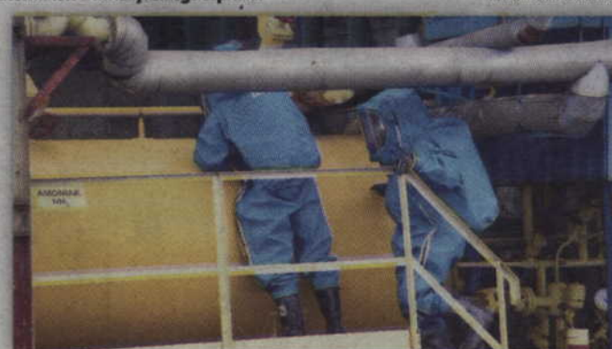
Strażacy sprawdzili szczelność zbiornika z amoniakiem.
