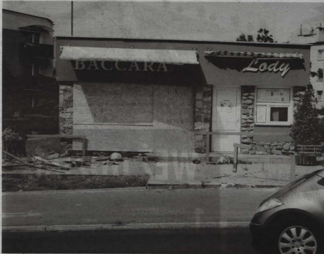
Zniszczenia w budynku handlowym są znaczne.
