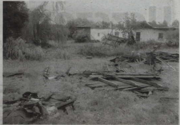
W Kowalach (gm. Prabuty) potężna wichura zerwała dach z domu jednorodzinnego.
