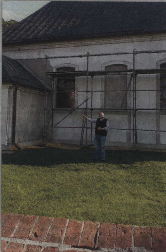
Ksiądz Andrzej Mamajek, proboszcz parafii pw. św. Stanisława Kostki nie ukrywa, że bardzo się cieszy z rozpoczęcia remontu elewacji.
