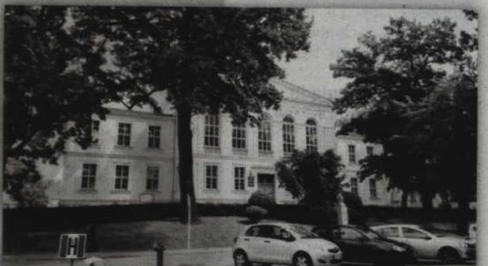
Wicestarosta kwidzyński podkreśla, że przygotowany zostanie taki front robót, aby prace nie kolidowały z normalnymi zajęciami. Na zdjęciu modernizowany obiekt ZSP nr 1. Fot. Mirosław Wiśniewski
