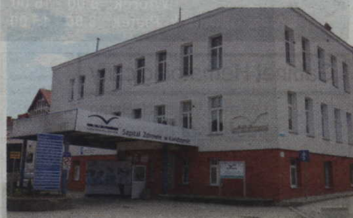
Remont jest częścią rozpoczętej w tym roku przebudowy i modernizacji kwidzyńskiego szpitala. Fot. Mirosław Wiśniewski
