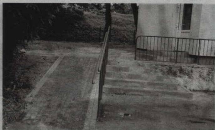
Budynek został powiększony o klatkę schodową. Wybudowano także wjazd dla osób niepełnosprawnych.
