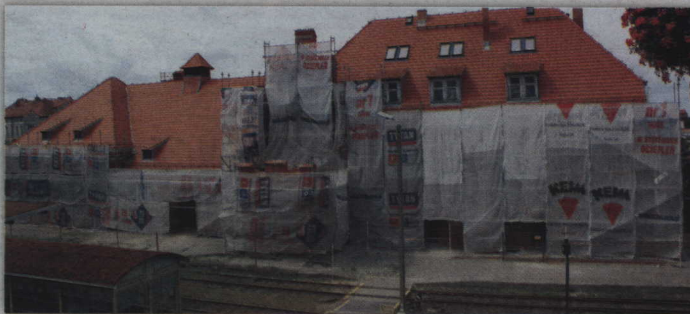
Trwa renowacja budynku dworca PKP oraz terenu wokół.
