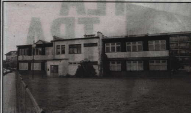
Samorząd miasta zamierza wyremontować budynek przy ul. Odrowskiego 10.
