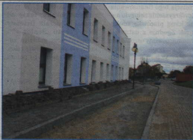
Aby dzieci mogły bezpiecznie dotrzeć do szkoły wykonany zostanie chodnik.
