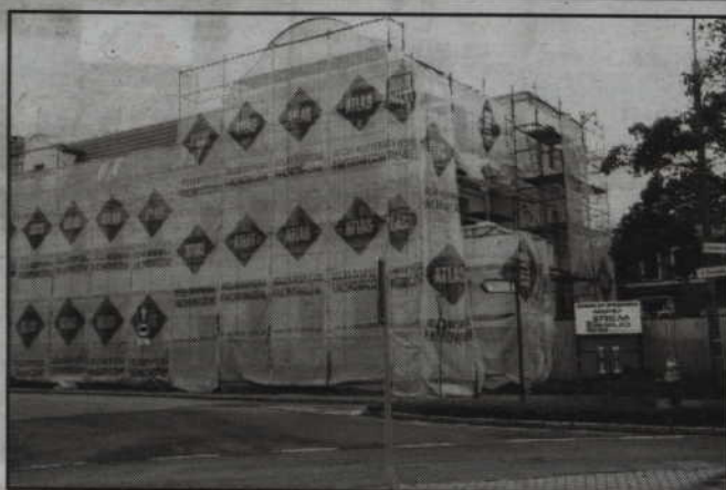
W budynku powstanie 12 mieszkań, po cztery na każdym piętrze.
